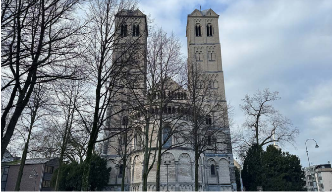
Ostfassade von St. Gereon. Foto: MiQua/Sebastian Ristow
